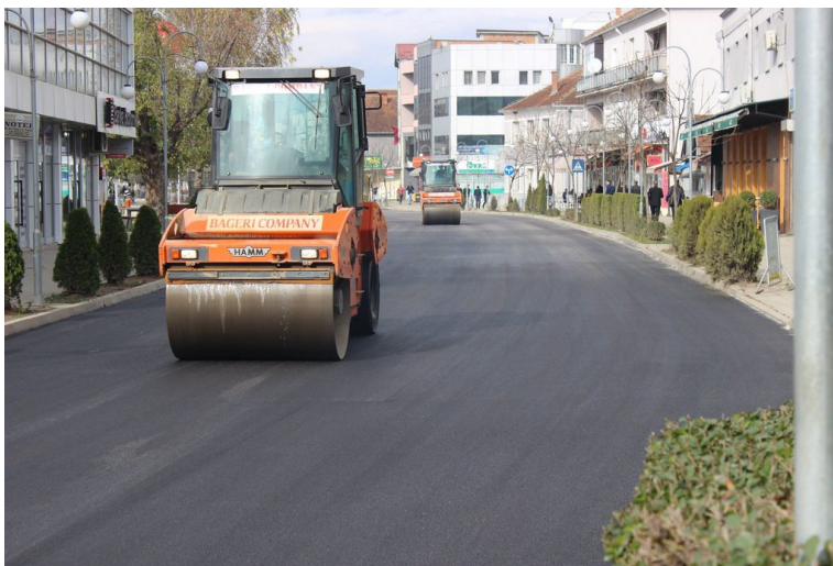
Proçesi i rrulimit të shtresës së asfalto-betonit
