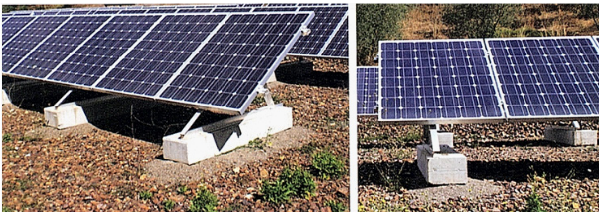
Figura 54: Fiksimi i sistemeve PV në tokë me blloqe betoni
