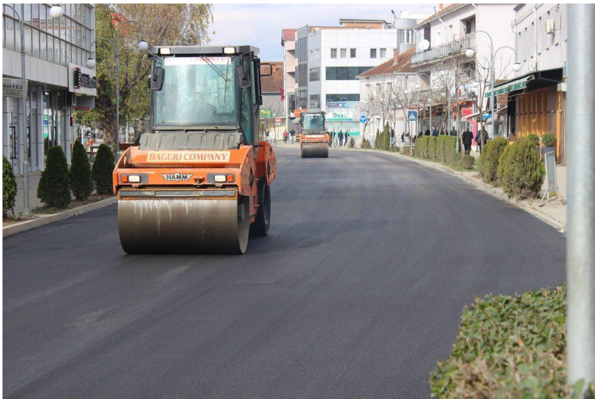
Proçesi i rrulimit të shtresës së asfalto-betonit
