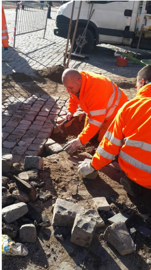
Mënyra e shtrimit të trotuarëve me gurë
