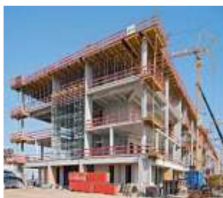
Foto. 11. Ndërtime skeletore të konstruksionit.
