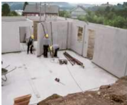
Foto. 6. Mure me panele b/a gjatë montimit.
