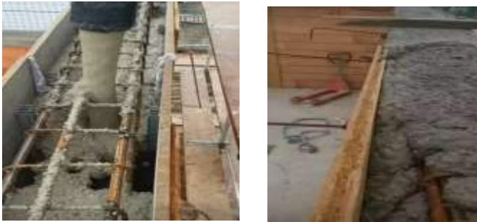
Foto. 13. Betonimi i trarëve të një ndërtese.
