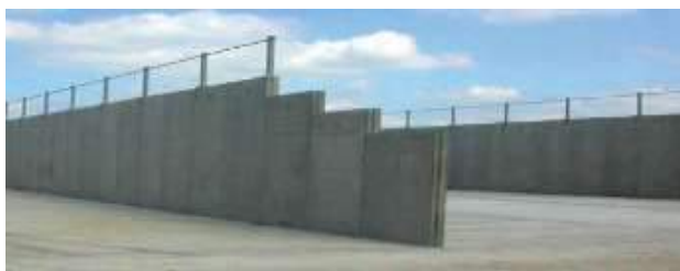
Foto. 4 . Mure rrethuese betoni vetëmbajtëse.
