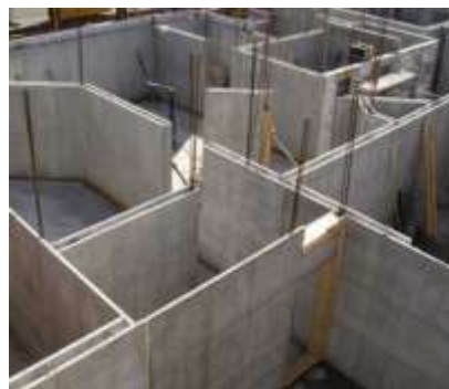
Foto. 6. Mure me panele b/a gjatë montimit.
