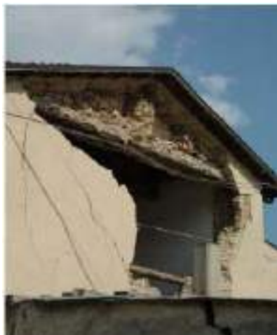
Figura 6 - Shkatërrim drejt pjesës së jashtme i muraturës midis dy hapësirave
