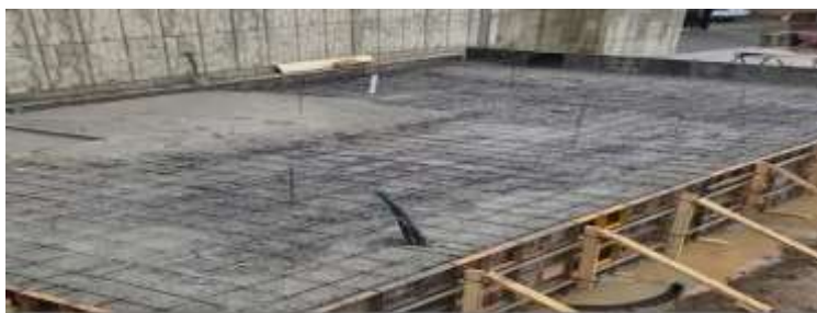
Foto. 6. Pllaka e katit përdhe e betonuar
