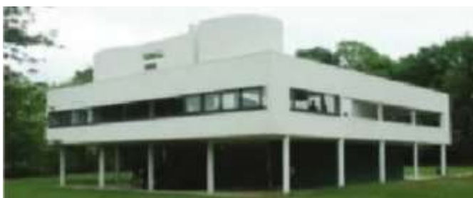
Foto. 7. Objekt i përfunduar me skelet beton – arme.
