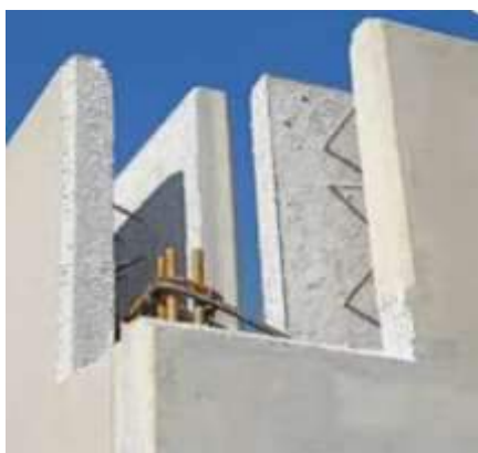
Foto. 5. Mure mbajtëse prej betoni të armuar.
