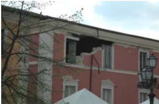
Figura 6 - Shkatërrim drejt pjesës së jashtme i muraturës midis dy hapësirave
