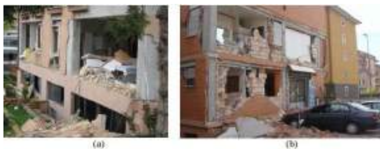
Figura 10 - Rrëzim i muraturës ndarëse perimetrale. Vini re: mungesë brezash
