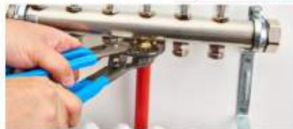
Fig.11.3.1 Lidhja e kolektorëve me tubat e qarqeve
