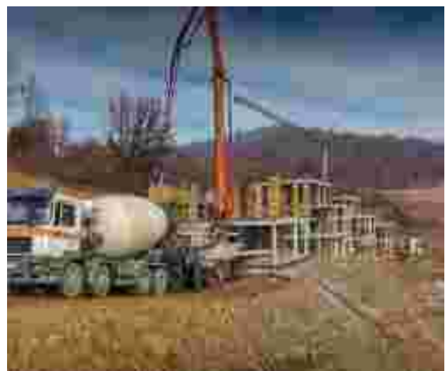
Foto. 43. Betonimi i kollonave prej betoni të armuar.
