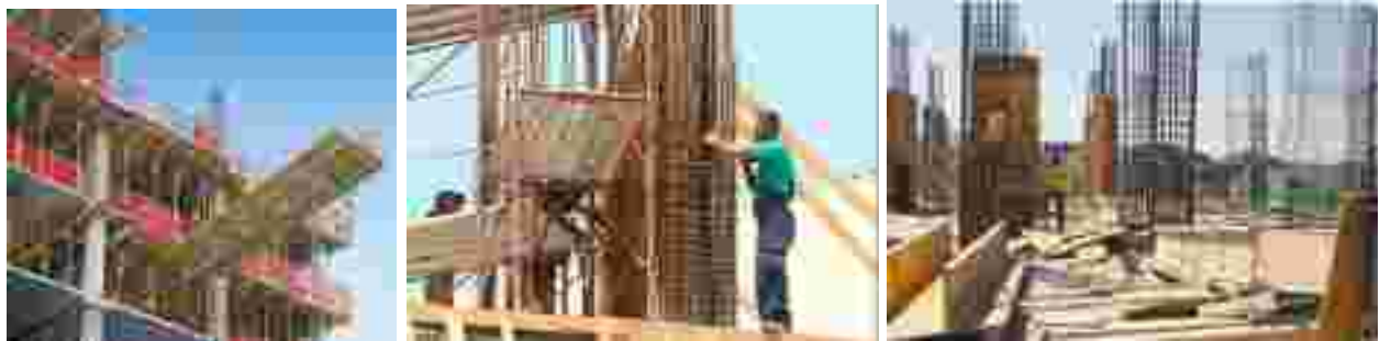
Foto. 35. Kallëpimi i pllakave (soletave) të ndërkateve dhe të kolonave.
