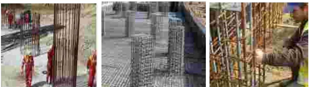
Foto. 37. Vendosja e armaturës së hekurit në kolona të llojeve të ndryshme dhe lidhja e tyre.
