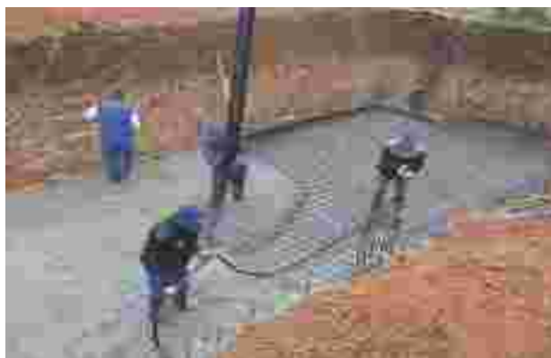
Foto. 19. Betonimi i themelit të rrafshët në formë pllake prej betonit të armuar
