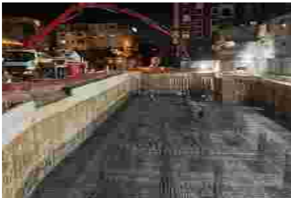
Foto. 19. Betonimi i themelit të rrafshët në formë pllake prej betonit të armuar
