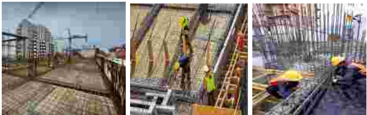
Foto. 36. Vendosja e armaturës së hekurit të pllakës së ndërkatit dhe trarëve dhe lidhja në skelet.
